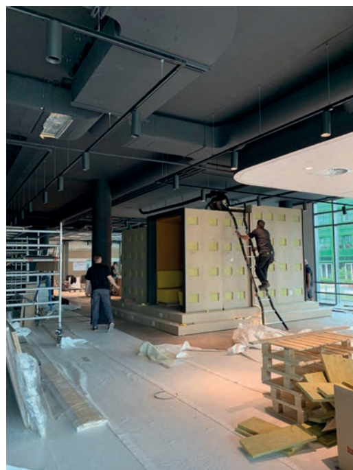
Foto gemaakt tijdens het bouwproces
